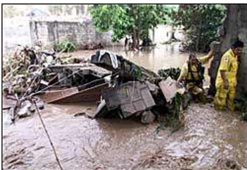
Muro que colapsó por la fuerza del agua de la quebrada El Garrobo.
