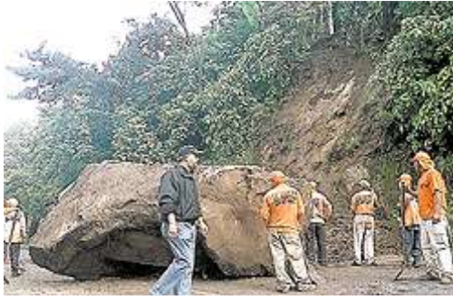
Empleados del Fovial esperan maquinaria pesada para taladrar la roca del deslizamiento en la carretera Panamericana a la altura de Los Chorros. Foto EDH
