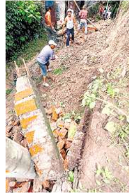
Daños. En el cantón San Antonio Abad la lluvia derribó un muro y dos postes del tendido eléctrico. Foto: EDH
