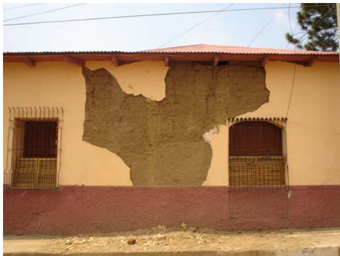
Foto 5: Caída de repello en casa de habitación en Salcoatitan.
