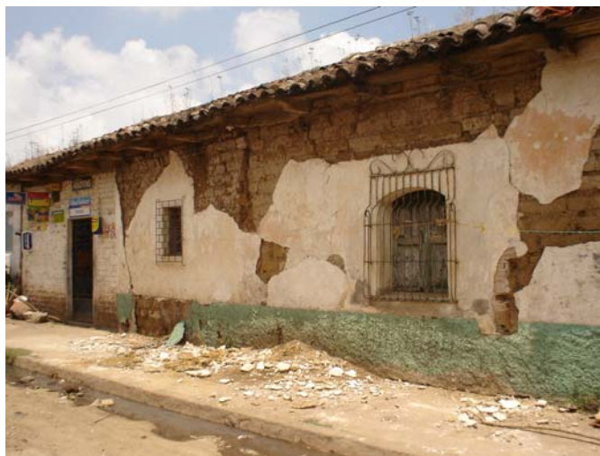
Foto 8. Caída de repello en vivienda de adobe. Apaneca.
