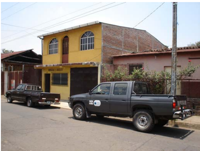
Foto 9. Vivienda de mampostería reforzada, sin daño. Juayúa.
